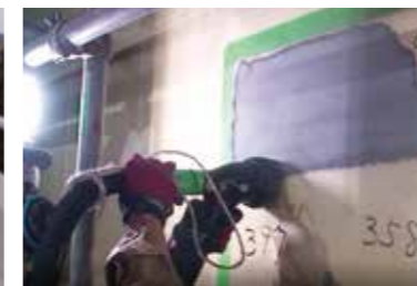
鋼板素地調整
