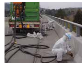
2人同時作業(橋梁高欄部の処理)
