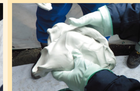
③十分に混ぜ合わせた後、材料を広げ均一に混ぜていることを確認し施工に移る。
