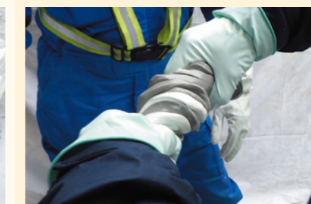
②軍手などを十分に水で濡らし、主剤・硬化剤を均一な状態となるまでねじ込む様に混ぜ合わせる。
