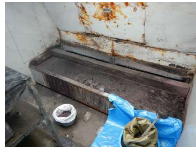
※上澄みは下水道へ排出。
