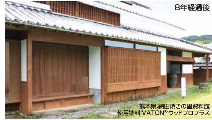
MOKリバブラスト処理 ひび割れも無くほとんど劣化は見られない。 テープで剥離しても着色層はほぼ剥 がれない。
