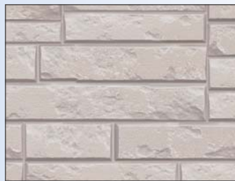
新築時／既存の外壁
